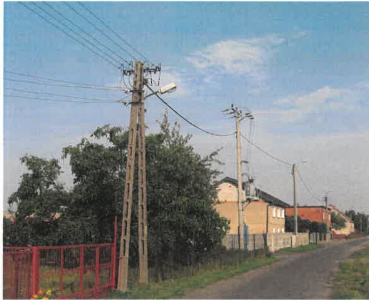
Fot. 5. Linie dystrybucyjne nn-0,4 kV (przykłady)
